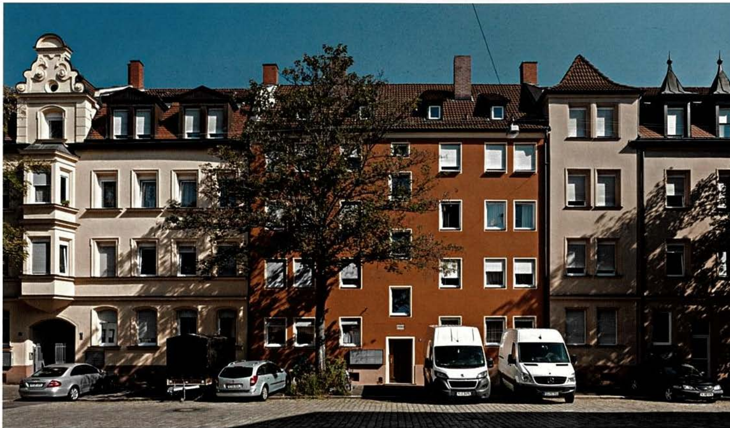
4 Mit der Fassadensanierung erhielten die Mehrfamilienhäuser in der Siemensstraße ihre ursprüngliche Farbigkeit zurück. Nun hat das Ensemble wieder ein stimmiges Gesamtbild.
